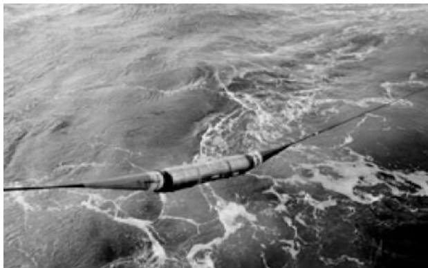
Рисунок 15 – Установка подводного оптического усилителя в открытом море [31]
