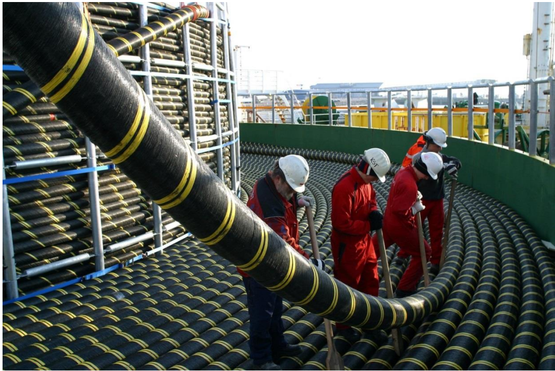
Рисунок 36 – Подводный кабель в бухтах
