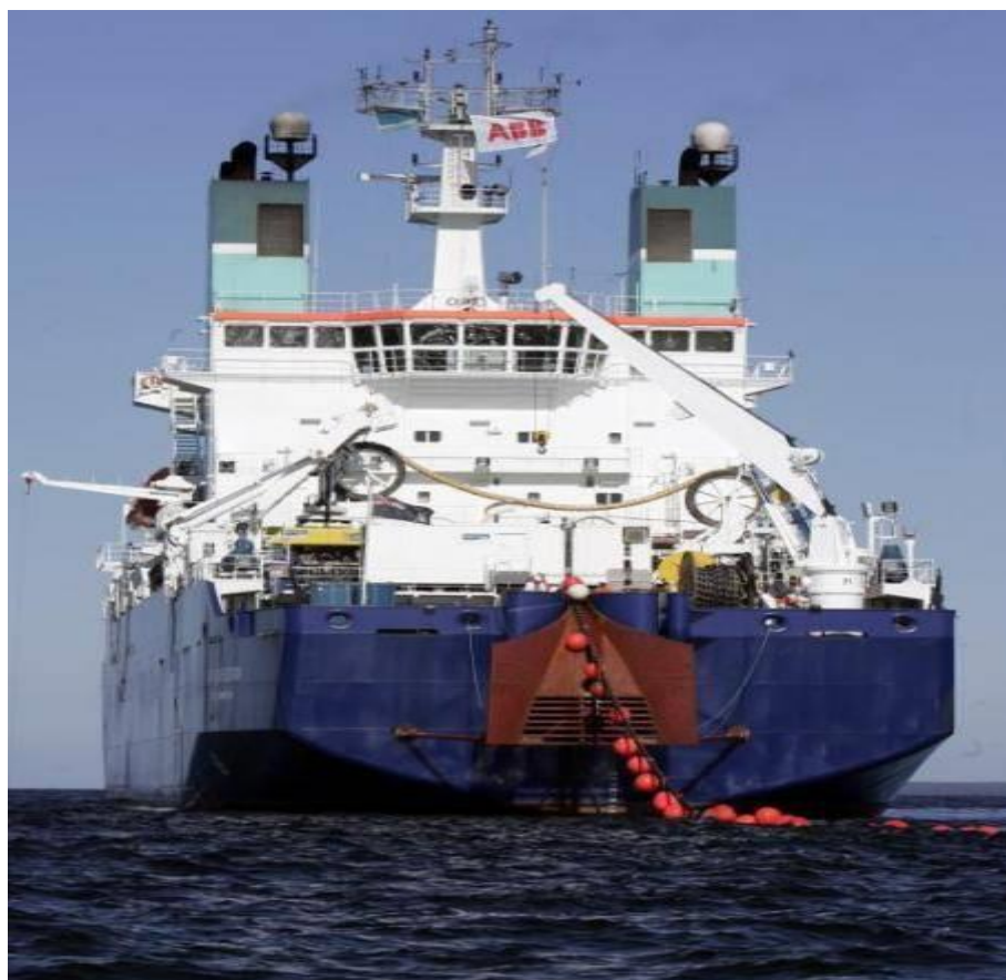
Рисунок 37 – Прокладка кабеля с корабля
